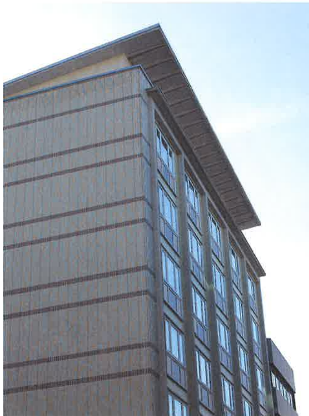
Abb. 8: Detailaufnahme der neuen Fassadenbekleidung, 2018 (Foto: Sabine Aumann)
