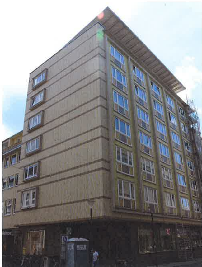
Abb. 7: Zustand nach der Sanierung, 2018 (Foto: Roswitha Kaiser)
