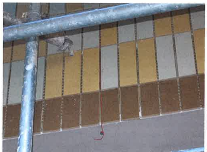
Abb. 6: Anlage einer Musterfassade am Objekt, 2017 (Foto: Sabine Aumann)
