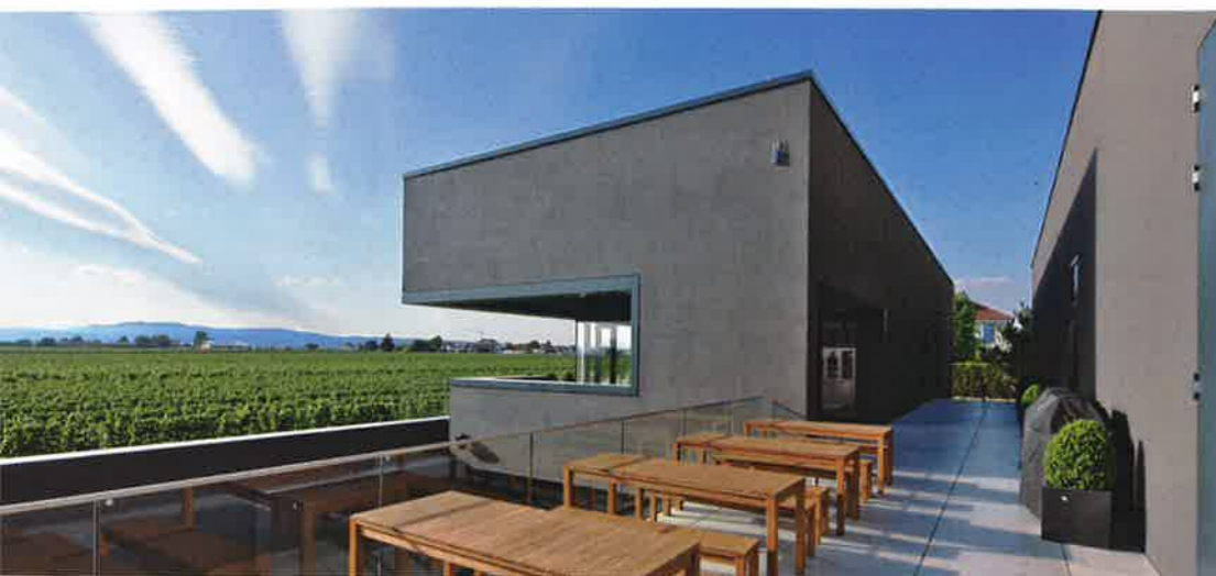
An den neuen Hallenkörper ist ein freistehendes Volumen angefügt. Das so genannte Loft besteht ebenfalls aus Betonhalbfertigteilen und birgt einen großen Festsaal mit einem Estrich in Sichtbetonanmutung
